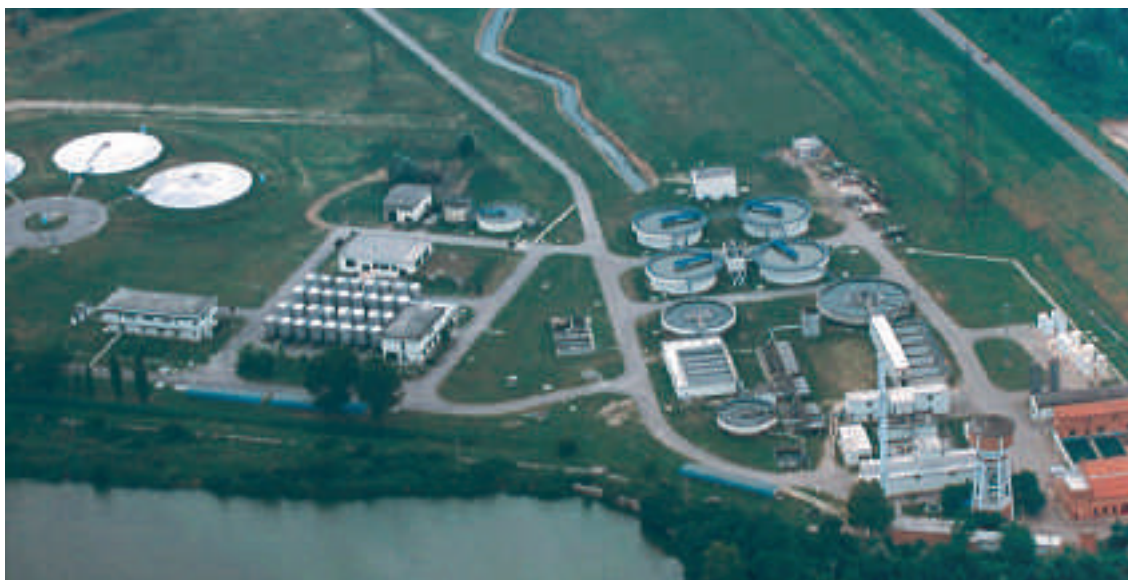
Centrale di Potabilizzazione di Pontelagoscuro
