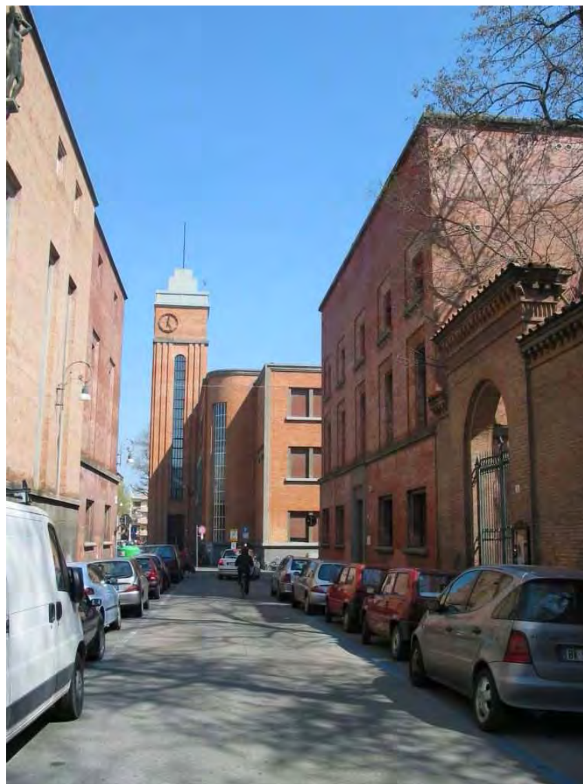
Gli edifici progettati da Carlo Savonuzzi nell'Addizione novecentista in via Boldini.
