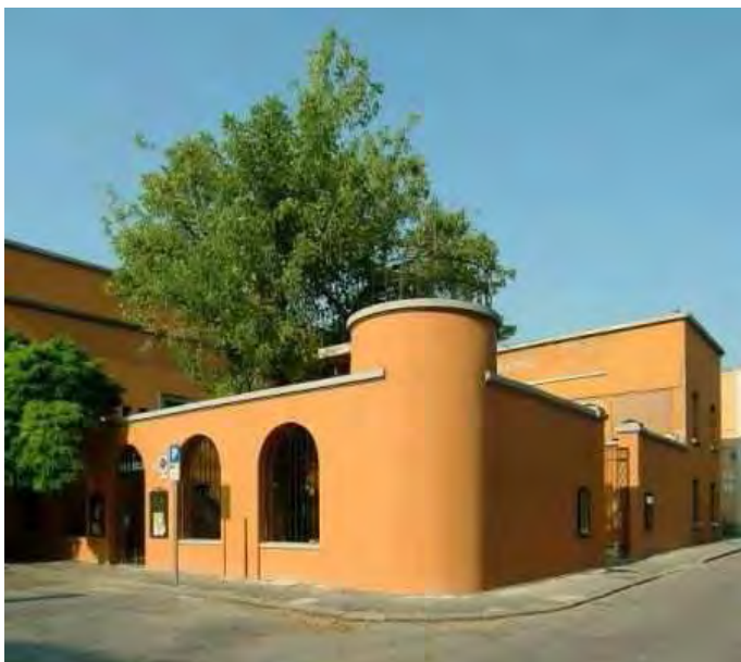
Complesso Boldini (ex Dopolavoro provinciale)
