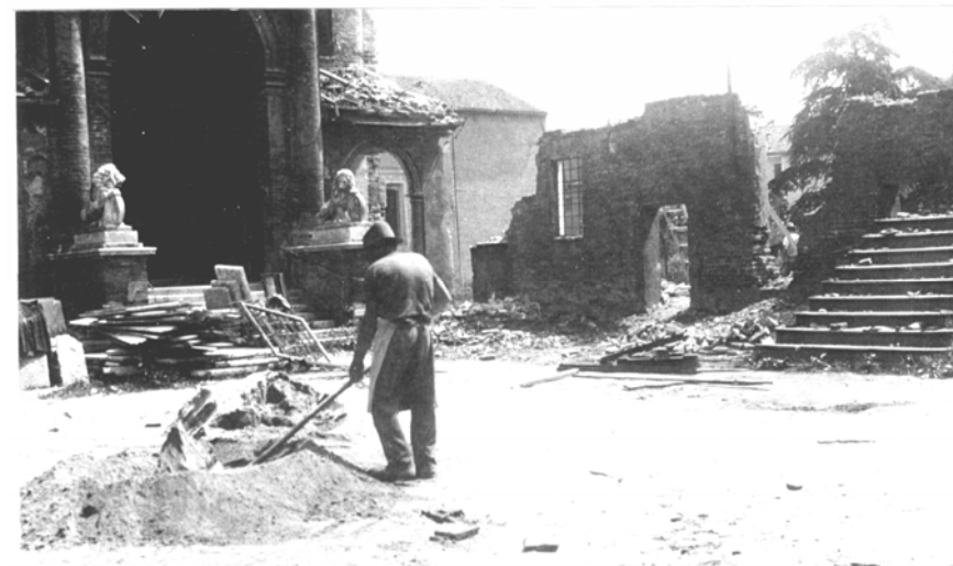
L'ex ospedale S. Anna all'inizio delle demolizioni, 1932 c.
