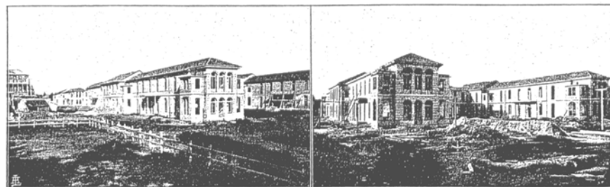
Nuovo Ospedale (Padiglioni). 1913 – Padiglioni in costruzione
