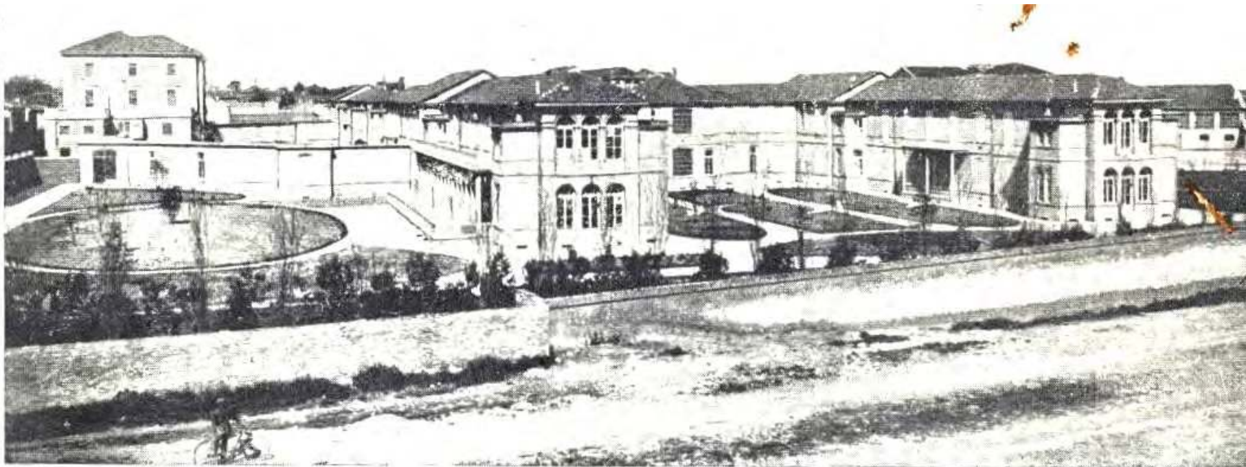
Impianto Sanitario del NUOVO OSPEDALE di FERRARA eseguito dalla Ditta DE CARLI - FERRARA con materiali in ghisa porcellanata delle FONDERIE AMBROGIO NECCH
