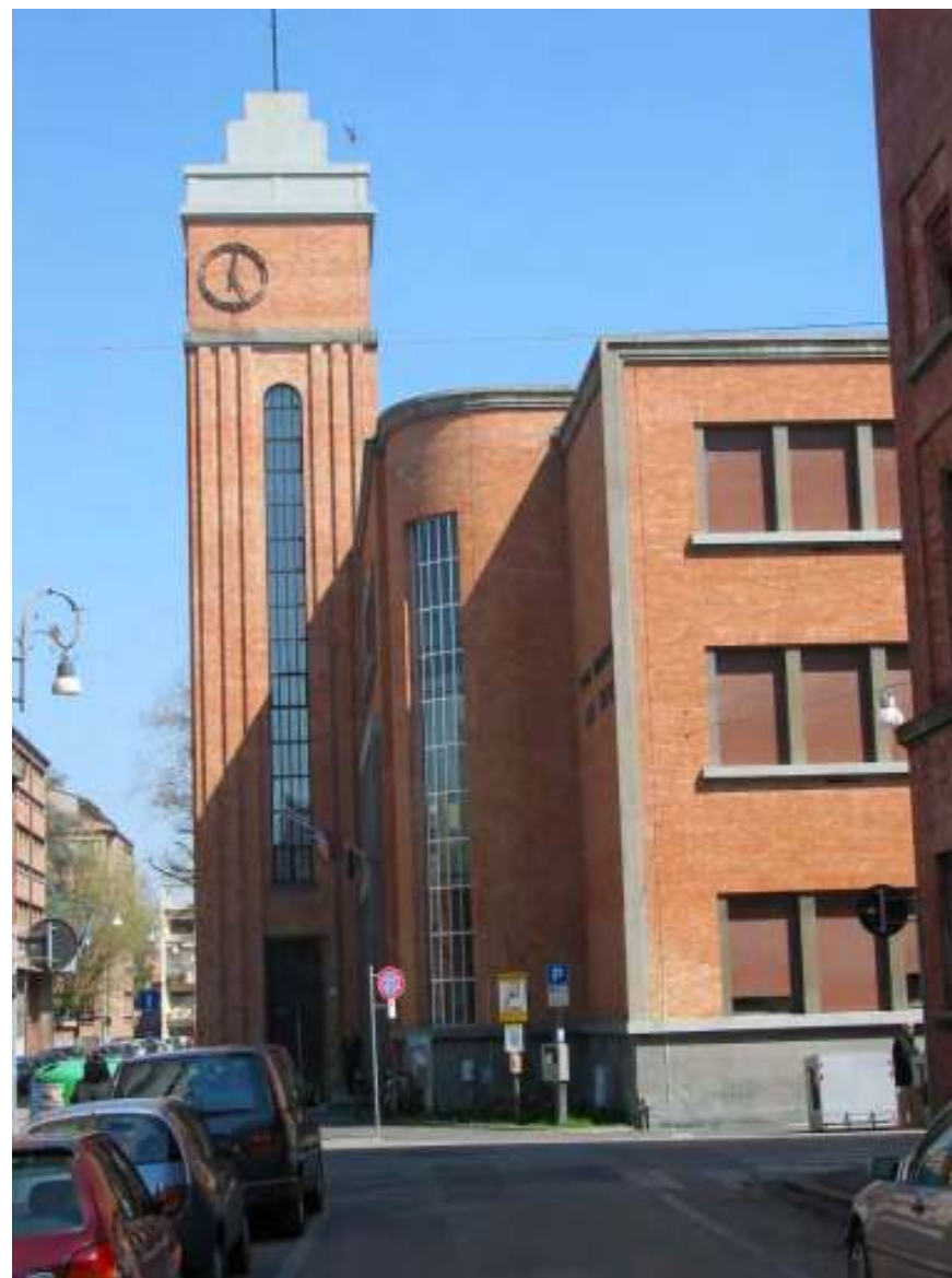
La scuola vista da sud
